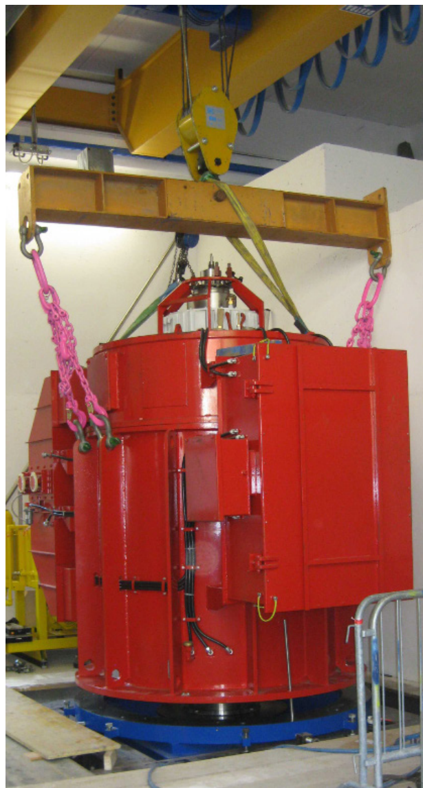
Slika 10. Kompletno opremljen i ugrađen generator
