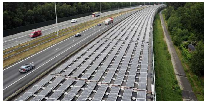
Slika 1: “Solarni tunel” koji će napajati super brze vlakove između Pariza i Amsterdam
